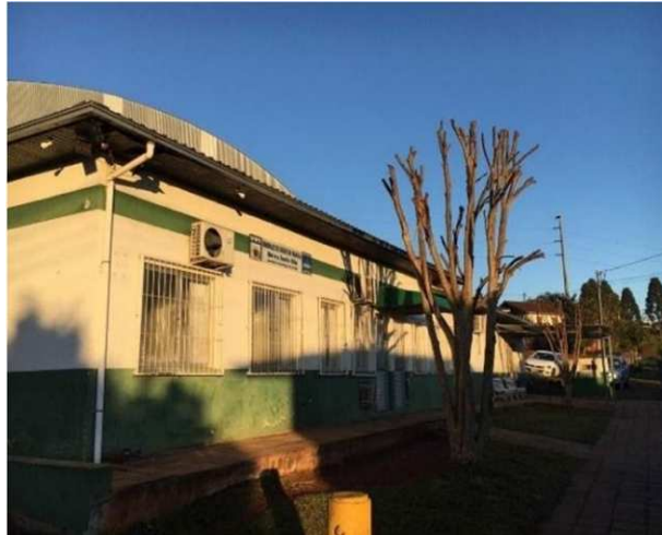
Figura 1. Registro fotográfico da estrutura física externa da ESF Santa Rita.
