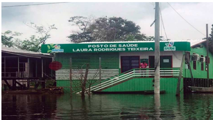
Figura 08: Posto de Saúde da Comunidade sendo tomado pelas águas do rio, Anori.
