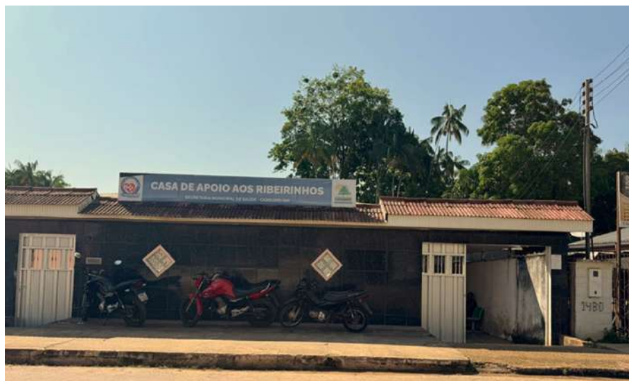
Figura 1. Imagem da fachada da Casa de Apoio ao Ribeirinho – Carauari.
